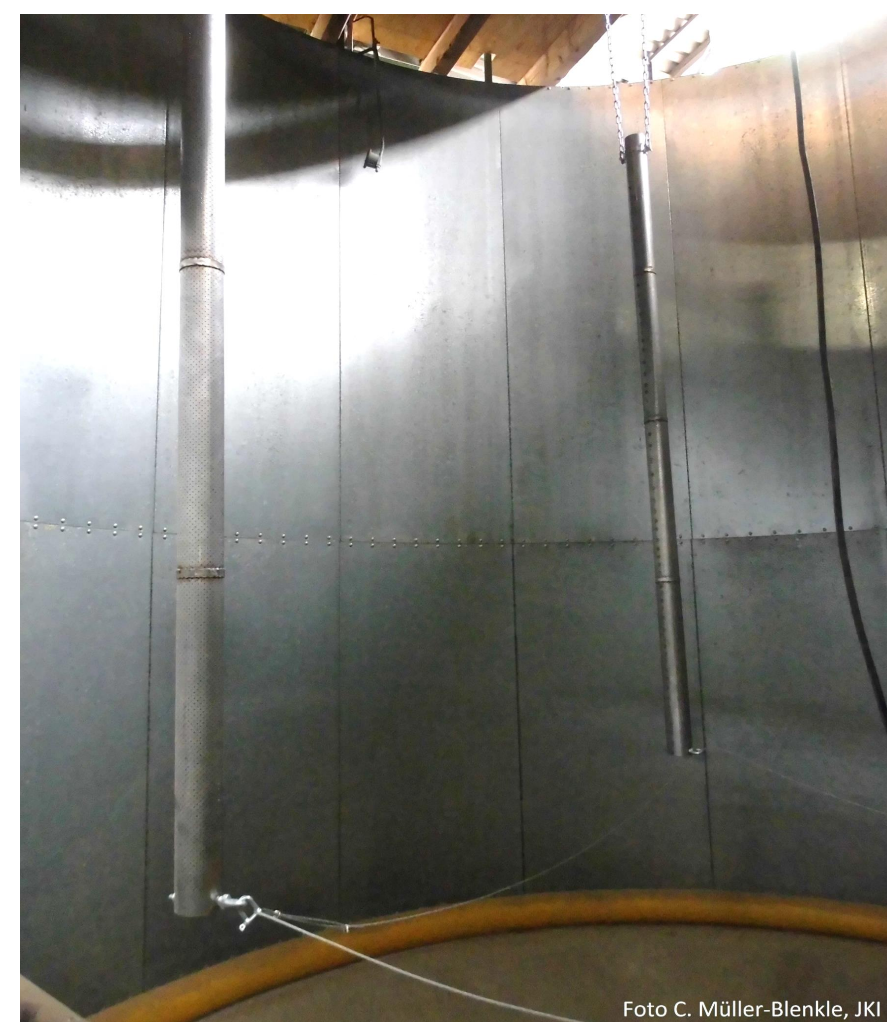
Installierte „Beetle Sound Tubes“- in einem noch leeren Silo in 2018
