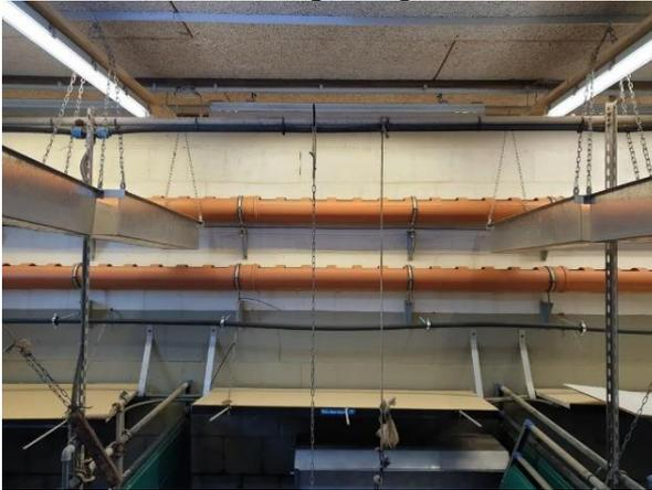
Abbildung 6: Schweinestall: zu erkennen ist das Wandrohrsystem (mittig hinten) und Abhängungen aus Edelstahl für Balkonkästen links und rechts
